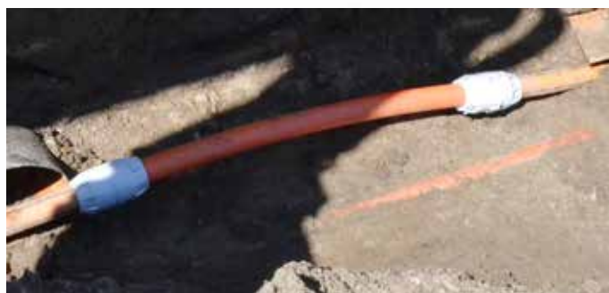
Havde der været installeret Trace-Safe, kunne en dyr reparation og mange gener for kunderne, med stor sandsynlighed været helt undgået.
