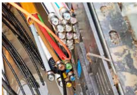
Installation af TST600W via indblæsning i et multirør med en ledig føringsvej.
