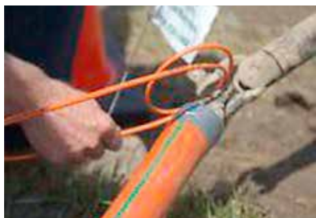
Forberedelse til styret underboring med RT1800W specielt til fiber-installationer.
