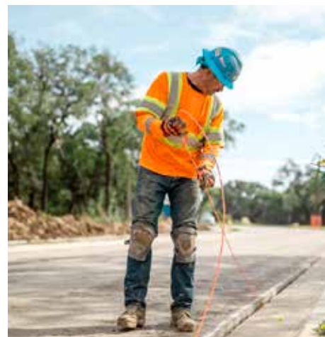
Her installeres TST600W manuelt i forbindelse med micro trenching, men kan med fordel indblæses i langt de fleste tilfælde.
